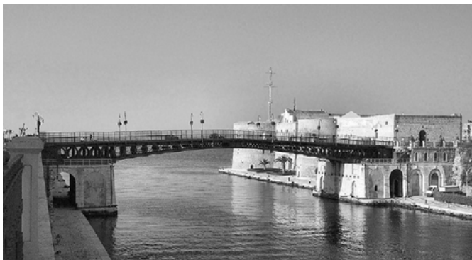
Fig. 1 “St. Francesco da Paola” bridge.
